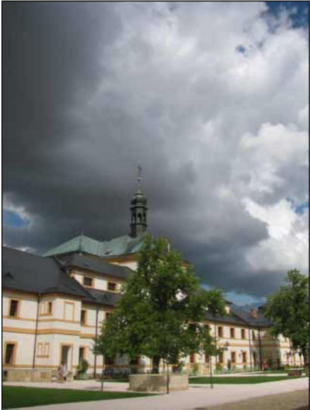
Revitalizovaný komplex hospitálu Kuks
