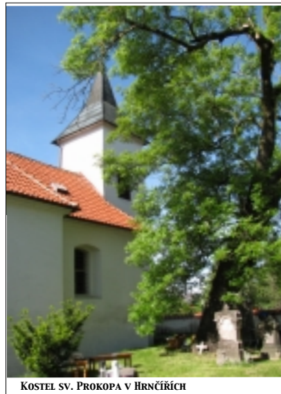
KOSTEL SV. PROKOPA V HRNČÍŘÍCH
